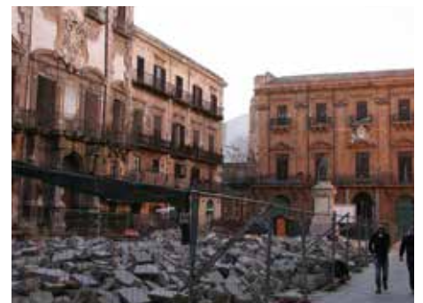
Piazza Bologni in ristrutturazione
